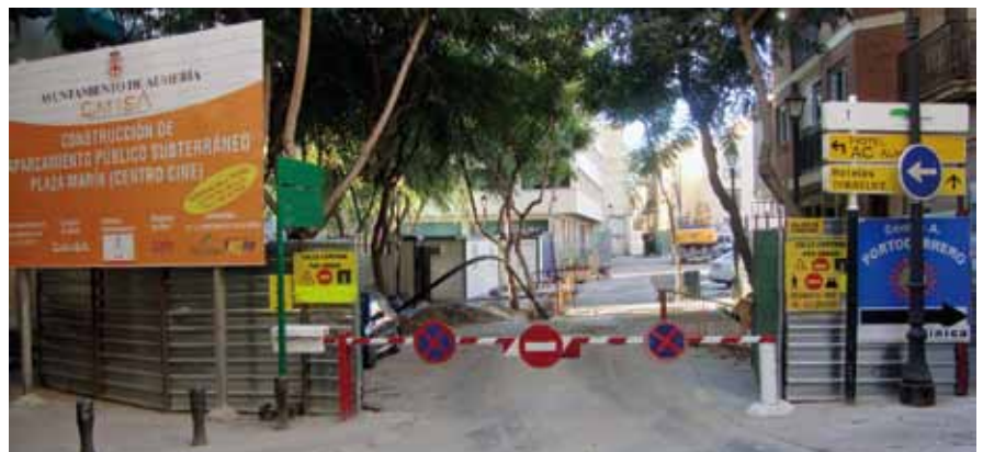
Plaza del Monte en obras.
